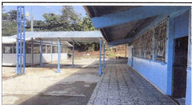
Foto 3: Así quedo la plancha de concreto.
