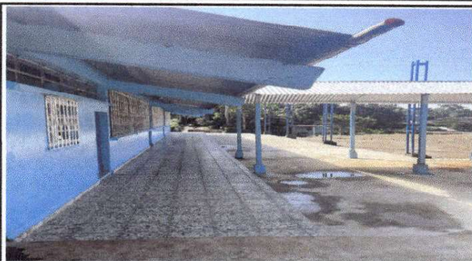
Foto 1: Así quedo el corredor principal con el piso de granito.
