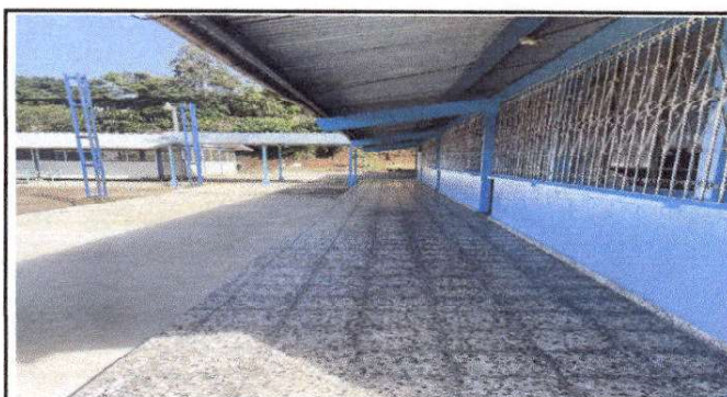
Foto 4: Finalizacion de la plancha de concreto dandole una mejora la la Escuela.
