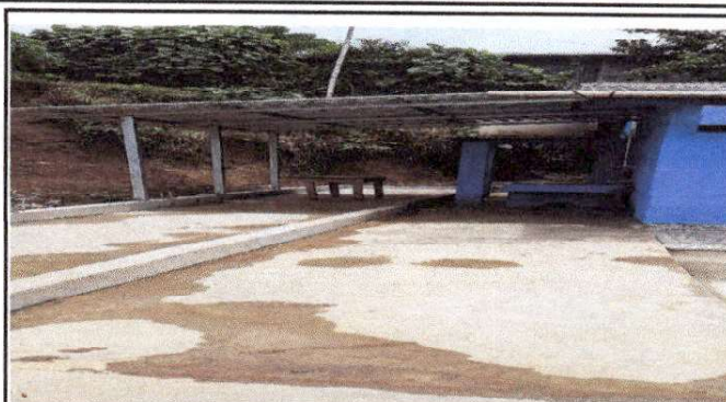
Foto 2: Terminacion de la galera con lamina traquelada.
